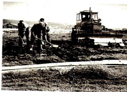
Grondwerkzaamheden voor de toekomstige Gerrit Stapelstraat.
