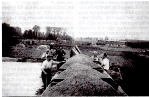
Rioleringswerkzaamheden voor de Begoniastraat, circa 1955.
